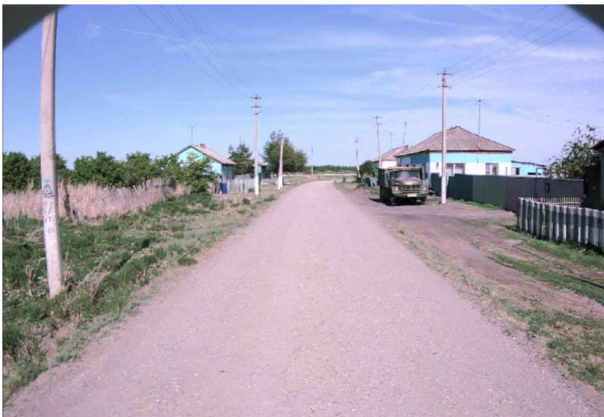
Рисунок 2.1.6 – Состояние покрытия на участке ПК 1+002
