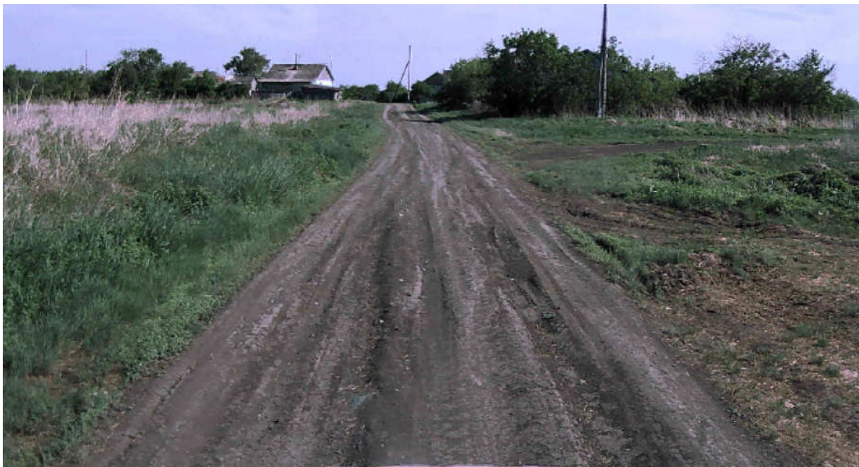
Рисунок 2.6.5 – Состояние покрытия на участке ПК 0+147
