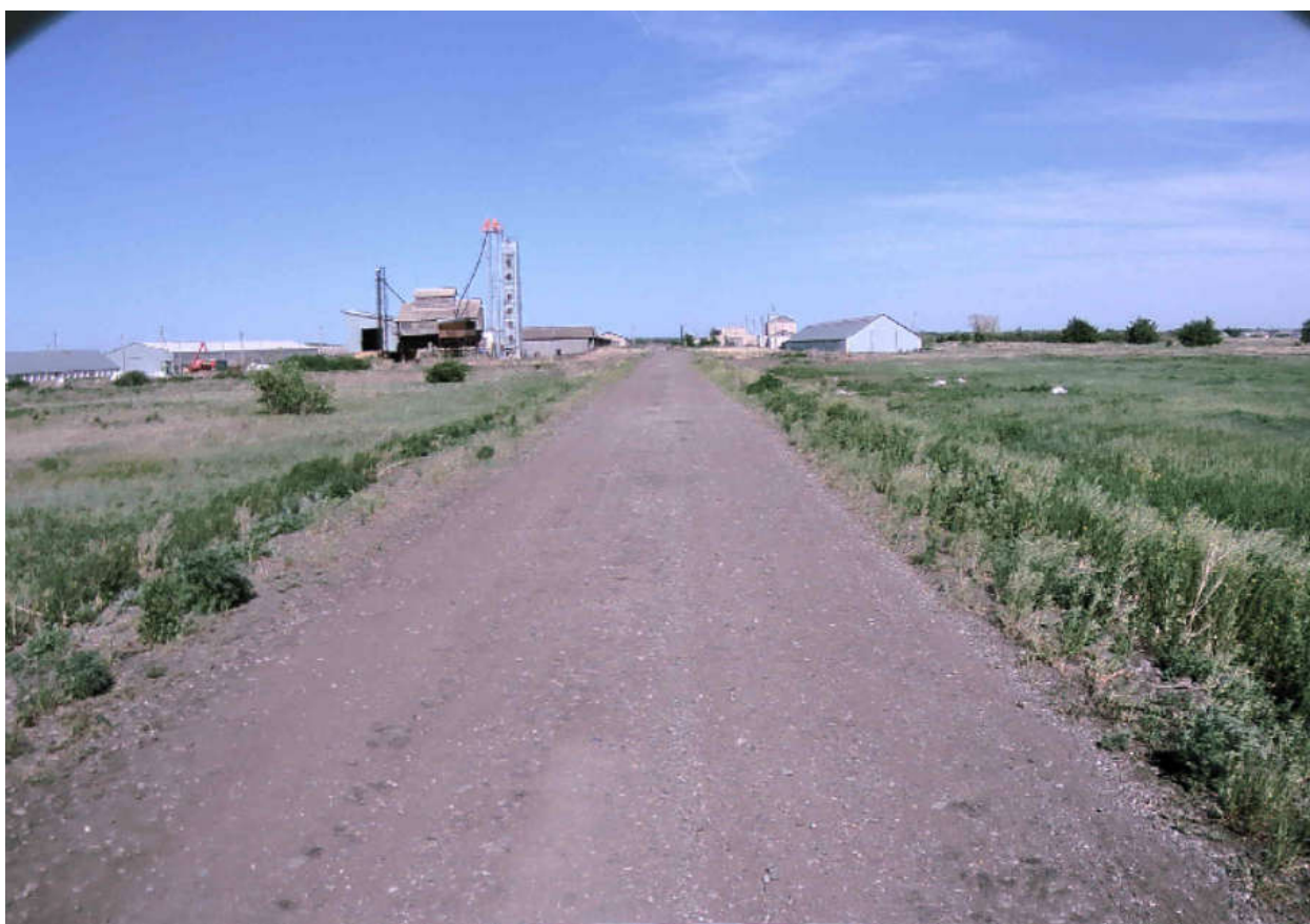
Рисунок 2.4.5 – Состояние покрытия на участке ПК 0+608
