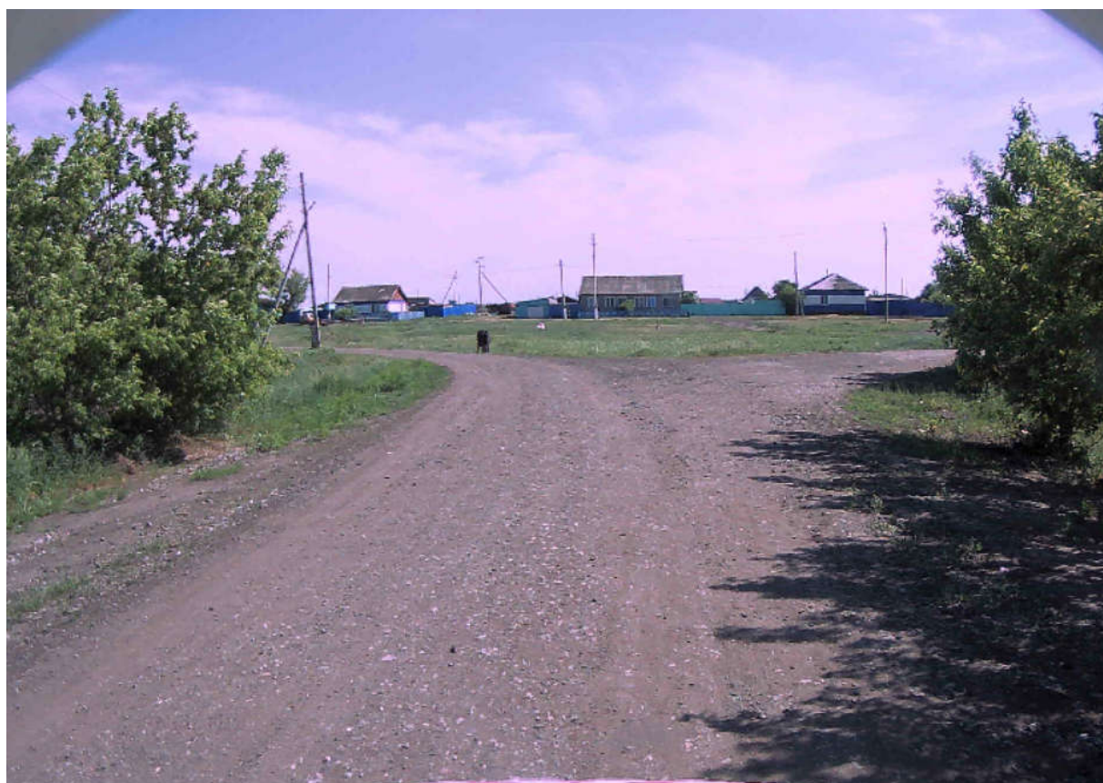
Рисунок 2.2.5 – Состояние покрытия на участке ПК 0+768
