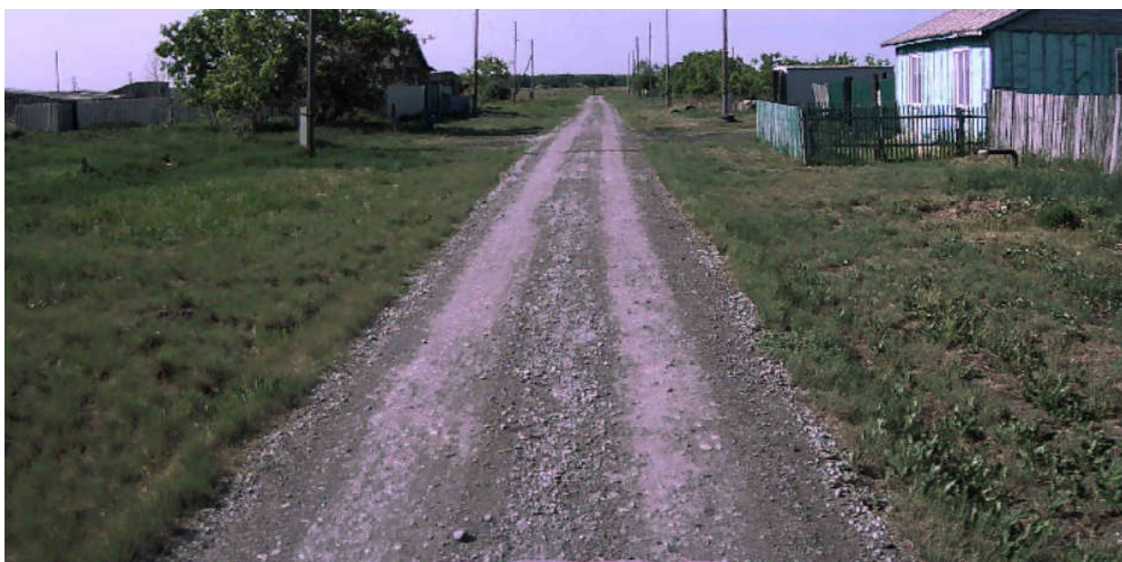
Рисунок 2.5.5 – Состояние покрытия на участке ПК 0+364
