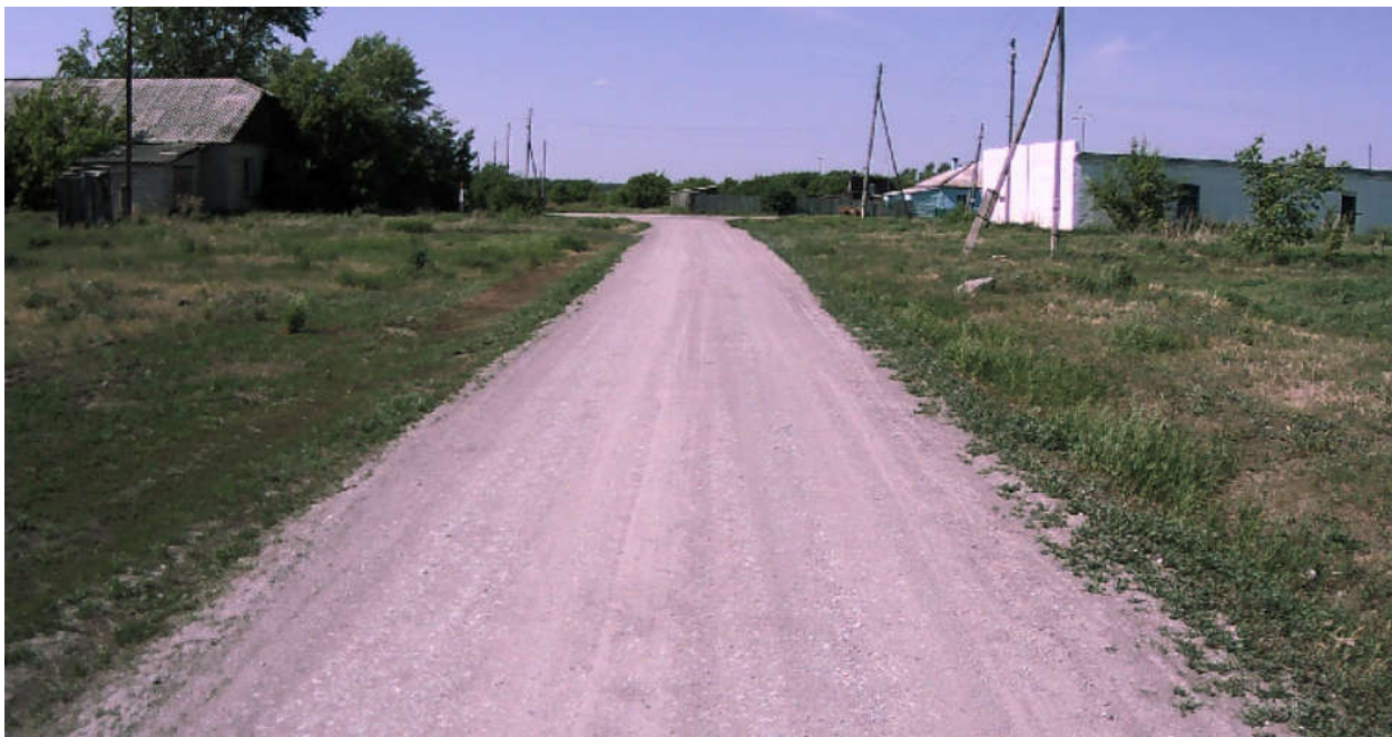
Рисунок 3.3.5– Состояние покрытия на участке ПК 0+255
