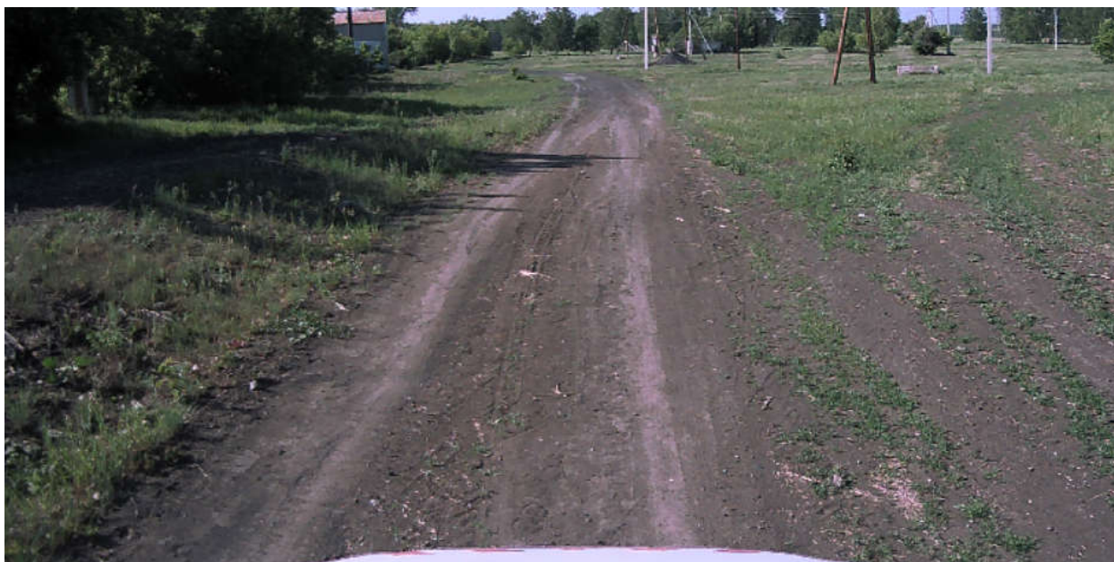
Рисунок 4.2.4 – Состояние покрытия на участке ПК 0+077
