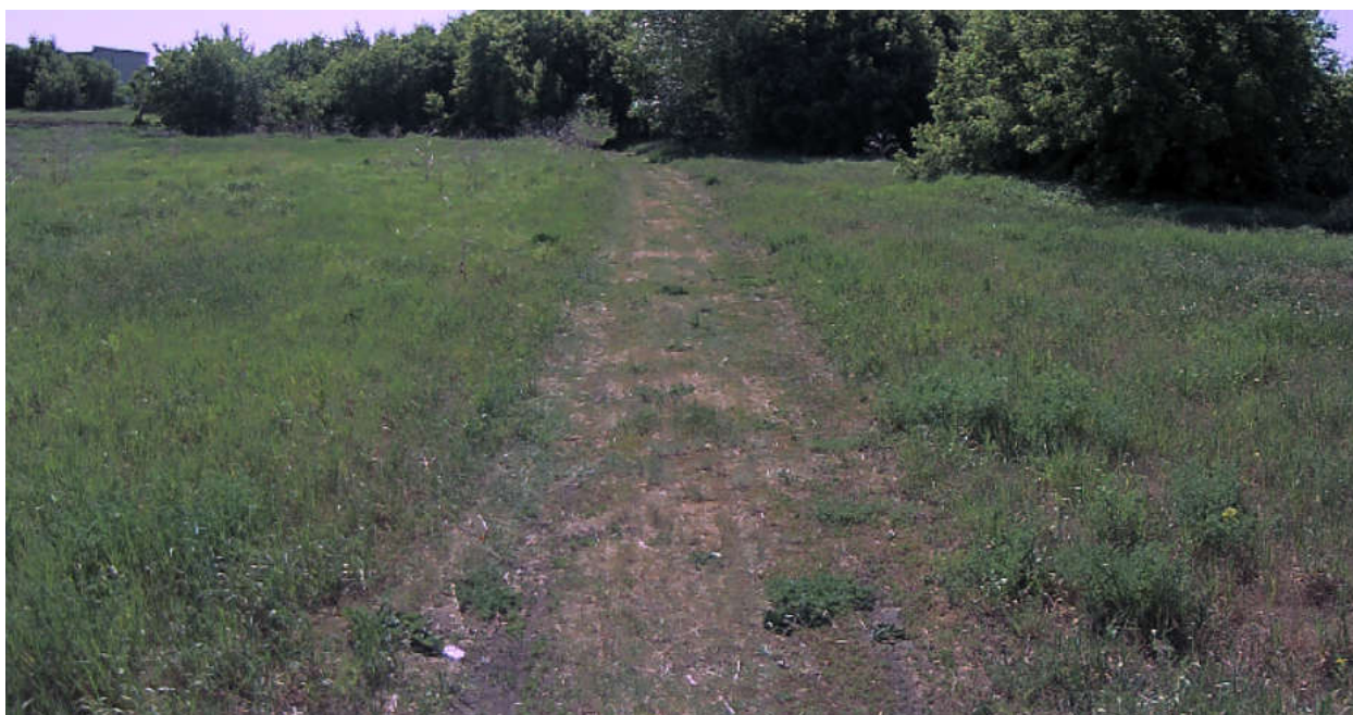
Рисунок 3.2.4 – Состояние покрытия на участке ПК 0+077
