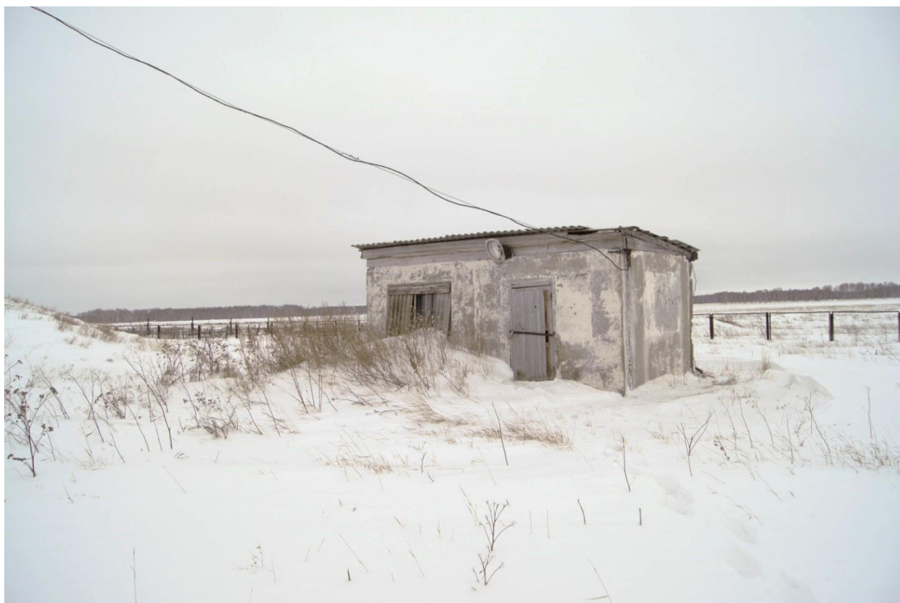
Рисунок 2.2 – Павильон скважины № 102-Г системы централизованного водоснабжения с. Успенка
