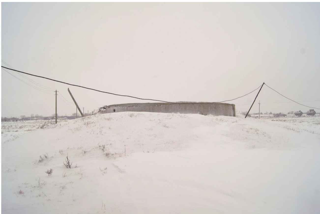
Рисунок 2.4 – Резервуар чистой воды вблизи скважины № 59 «Г»
