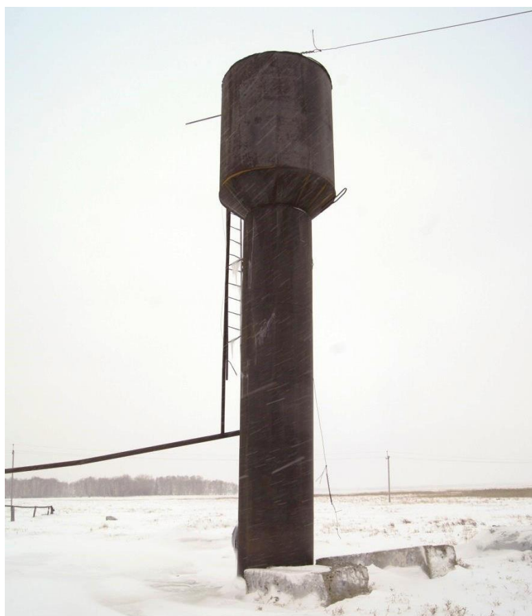
Рисунок 2.3 – Водонапорная башня системы централизованного водоснабжения с. Новоалександровка
